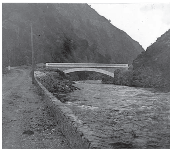
Puente de Rey – Final de la cordillera oriental
